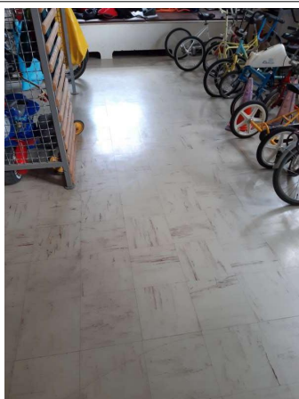
Déclaré - : RDC / SALLE DE REEDUCTION - Dalle de sol - EP - (Présence d'amiante)
