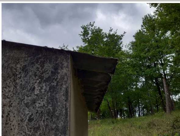
Déclaré - : EXTERIEUR / LOCAL PISCINE - Plaque ondulée - EP- (Présence d'amiante)
