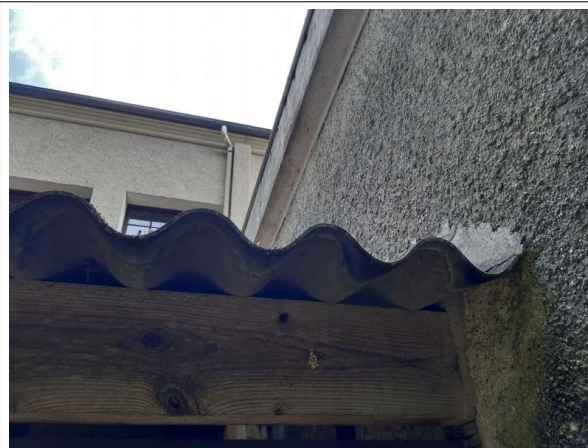
Déclaré - : EXTERIEUR / AUVENT - Plaque ondulée - EP- (Présence d'amiante)
